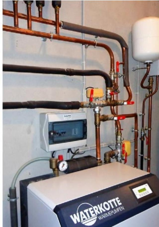
*Mise en place de 145m<sup>2</sup> RDC+ étage de plancher chauffant et rafraichissant et géothermie sur capteur horizontal sur 300m<sup>2</sup>*
