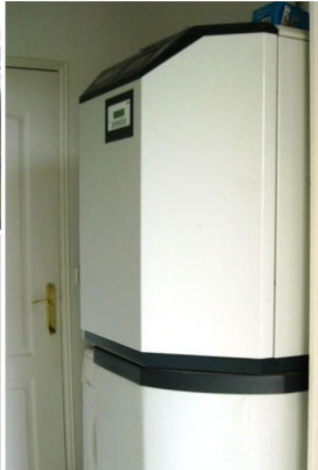
*Installation d'une PAC monobloc, eau/eau (1,9m<sup>3</sup>/h), plancher chauffant / rafraîchissant RDC et ETAGE (158m<sup>2</sup>). Modèle Ai1 avec eau chaude intégré (250litres). Froid naturel (pas de fonctionnement du compresseur)*
