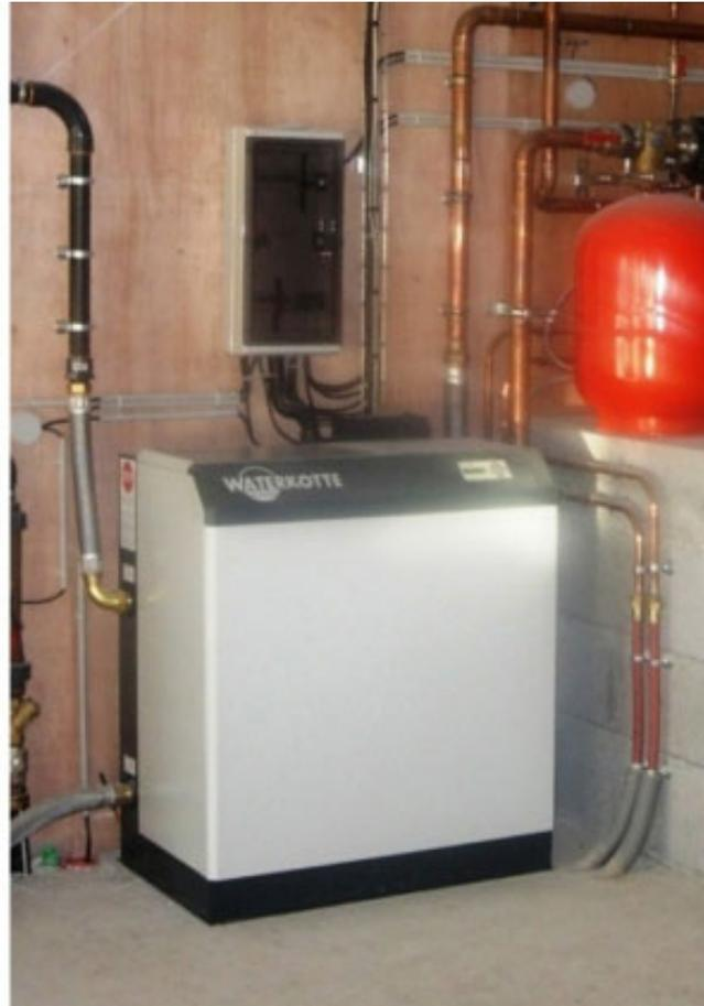
*PAC eau/eau (7,5m<sup>3</sup>/h), plancher chauffant / radiateurs (ballon tampon 500 litres, vanne mélangeuse). RdC, 1 et 2 étage (977m<sup>2</sup>); 11 Salles de bains. Ballon d'eau chaude de 500 litres avec la même PAC (production de 500 litres en 1/4 heure sans résistances)*
