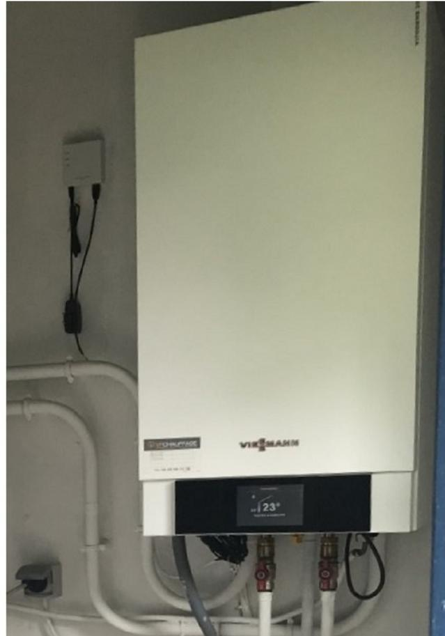
*Chaudière VIESMANN Vitodens à condensation sur radiateurs + Ballon d'eau chaude sanitaire 300L Vitocell. Installation et entretien de la pompe à chaleur piscine ZODIAC.*
