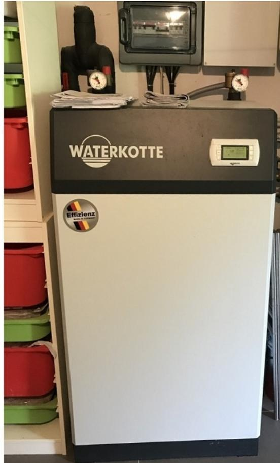
*Installation d'une pompe à chaleur WATERKOTTE triphasé pour planché chauffant, de 200m<sup>2</sup> rdc + étage 138m<sup>2</sup> ( 8 radiateurs basse température, ballon tampon double température), ballon d'eau chaude sanitaire instantané 400L anti légionelle. Chauffage piscine titane automatique depuis chaufferie.
