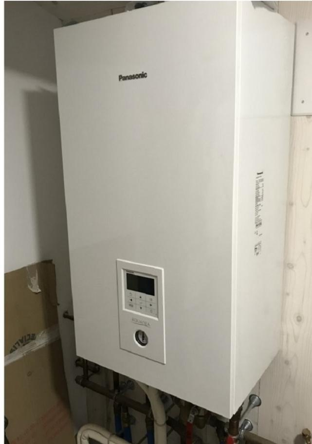
*Installation d'une pompe à chaleur Panasonic Aqueara hautes performances pour plancher chauffant de 125 m<sup>2</sup>. (renovation complète)*
