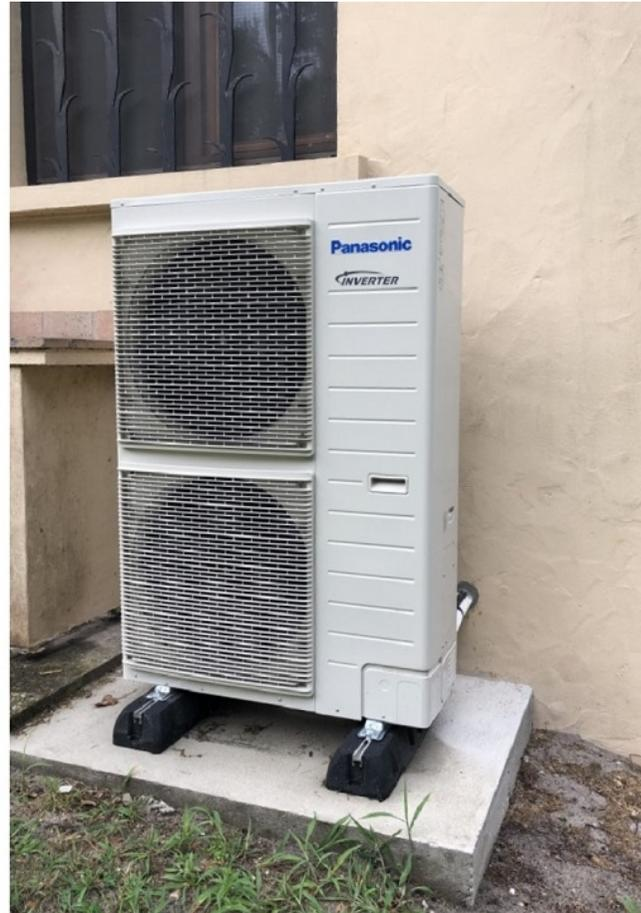
*Remplacement d'une chaudière bois par une pompe à chaleur T-CAP 16 KW triphasé (65°C) PANASONIC et d'un ballon tampon de 100l. Raccordement en parallèle d'un réchauffer TURBO FREIN par entraînement de la roue du moulin (priorité du chauffage au TURBO FREIN).*
