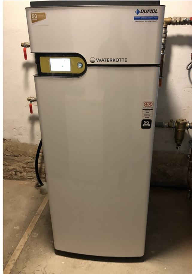
*Installation d'une pompe à chaleur sur captage Horizontal 700m<sup>2</sup> à 60m de la chaufferie. Capteur de 100m de long. Sur chauffage central existant remplacement de quelques radiateurs et remplacement d'une chaudière fuel.*
